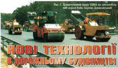
Щебенево-мастиковий асфальтобетон (ЩМА) був розроблений в кінці ХХ століття в Німеччині й одержав назву «Splittmastixasphalt» (SMA). Він з'явився як наслідок боротьби дорожніх служб Німеччини з інтенсивним руйнуванням дорожнього покриття й утворенням колії через ріст інтенсивності та вантажонапруженості автомобільного руху. За роки свого використання суміші ЩМА продемонстрували прекрасні експлуатаційні якості.
